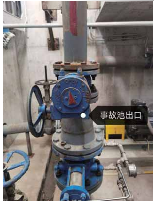
事故水池出口
