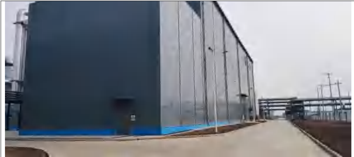
空分空压机厂房
